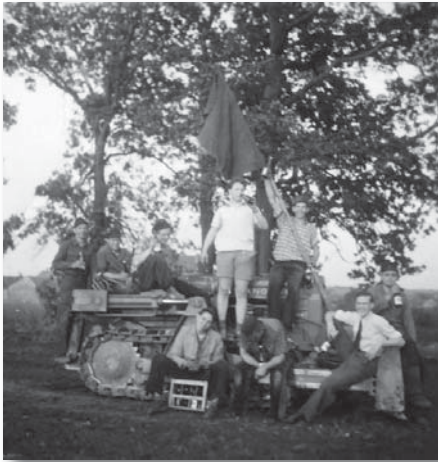
Arbeiten an der Hohnsheck mit der Hanomag Raupe der Firma Scheiff Josef Roitzheim (1. v.r.), Josef Mertens (2. v.r.), Franz Löhr (mit Fahne), Berthold Wiskirchen (Mitte stehend), Josef Wiskirchen (links daneben)
